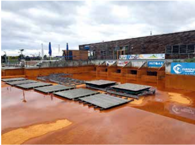
Die Pumpen sitzen unter dem Hauptgebäude des Kanuparks.
