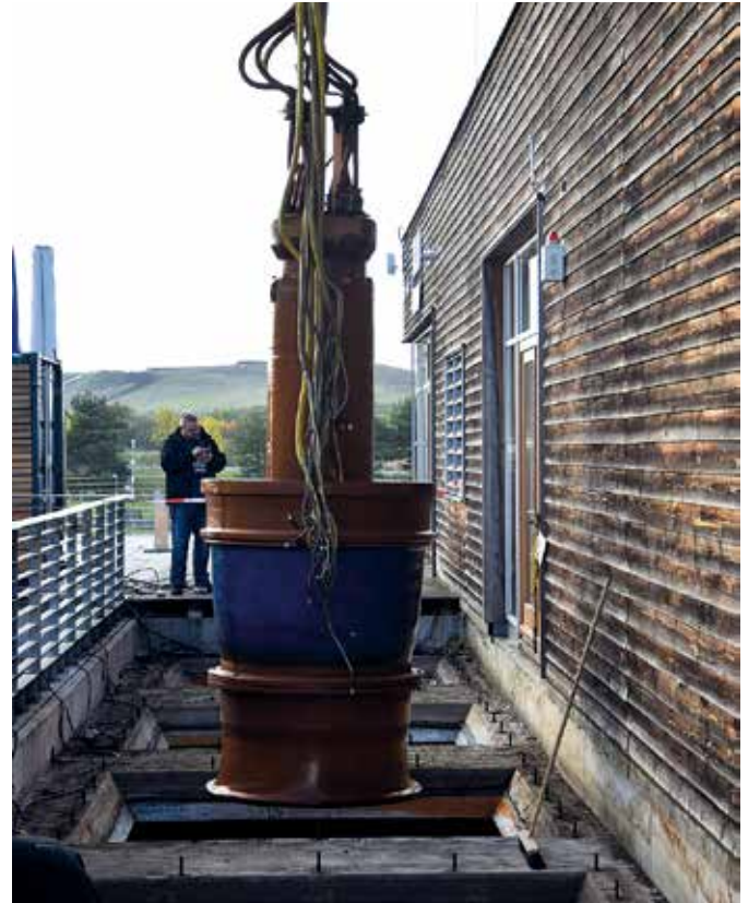
Eine sieben Tonnen schwere Pumpe wird vorsichtig aus dem Schacht gezogen.
